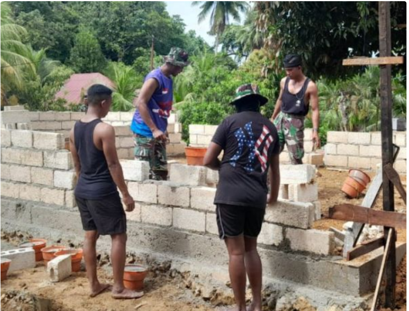
Satgas TMMMD Ke-122 Kodim 1429/Butur Terus Dikebut Rehab RTLH
